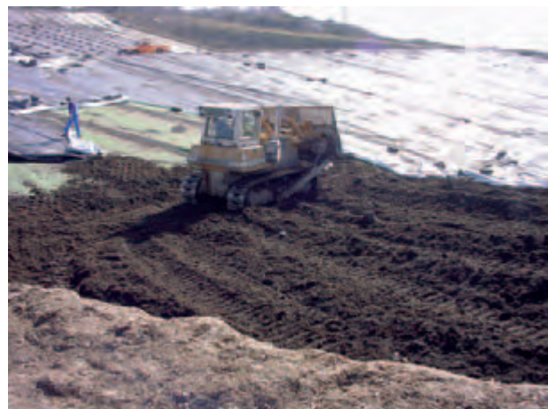
Bild 2: Verteilung des MBA-Materials auf der Einbaufläche
