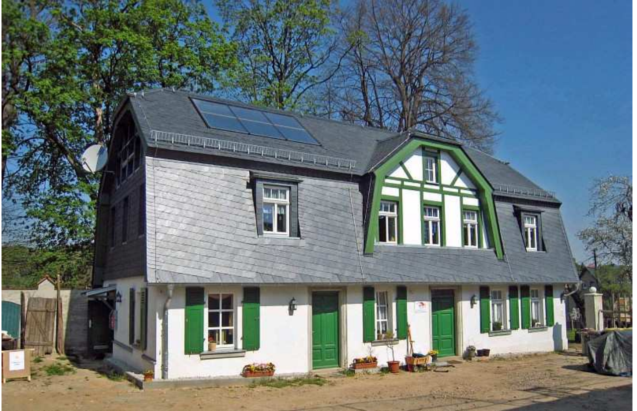
Jugend- und Begegnungszentrum Bauerngut Rödlitz, denkmalgeschützter Dreiseithof mit 10 m 2 Solaranlage
