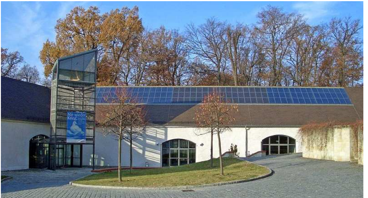
Bischof-Benno-Haus in Schmochtitz, 78,8 m 2 Solaranlage auf 200 Jahre alter, denkmalgeschützter Scheune
