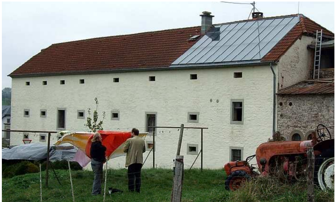
Solaranlage mit 40m 2 in Gransdorf auf einem denkmalgeschützten Bauernhof
