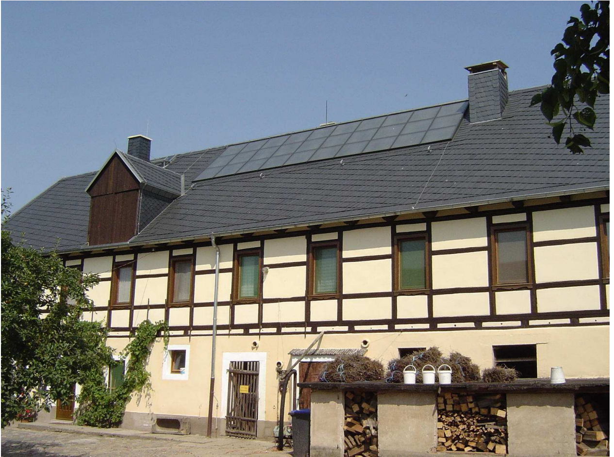
Sonnenwärmeeanlage zur Heizungsunterstützung und Warmwasserbereitung auf einem denkmalgeschützten Hof.
