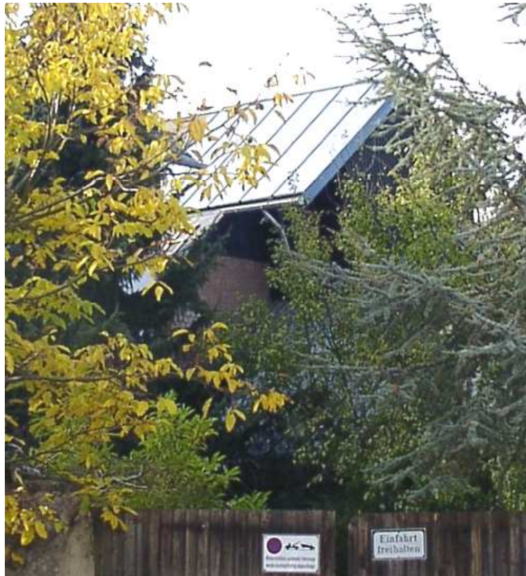
Solaranlage mit 20 m 2 im Ortskern von Trier-Pfalzel (Denkmalzone)
