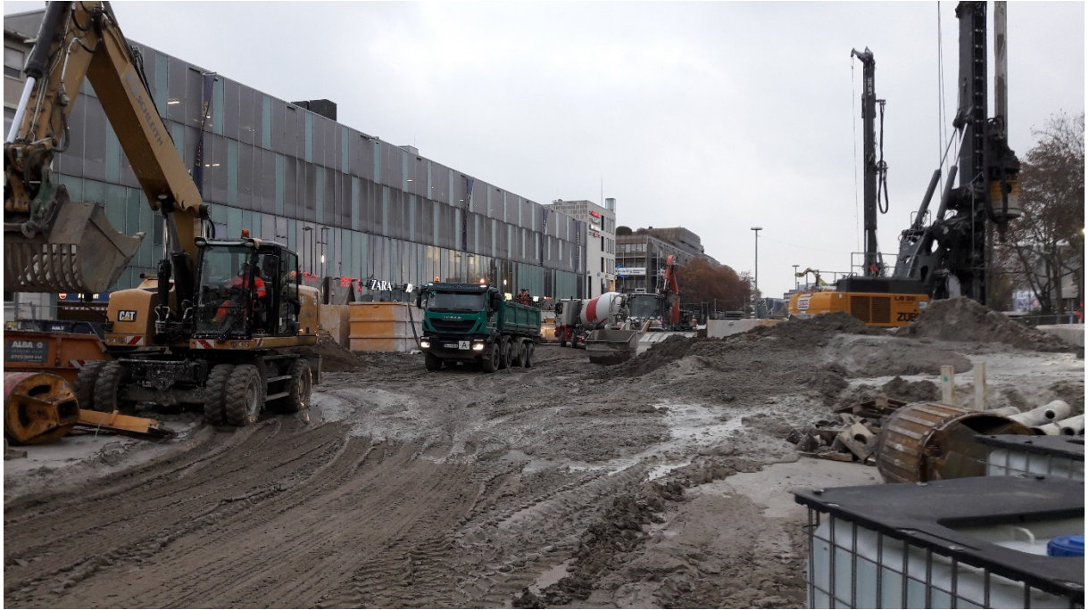
Bild 5: Baustelle Tunnel Kriegsstraße in Karlsruhe; Bagger - LKW Betrieb
