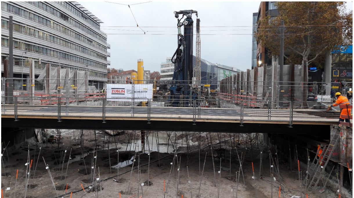
Bild 2: Baustelle Tunnel Kriegsstraße in Karlsruhe; Weichgelsohle und temporäre Stahlbehelfsbrücke
