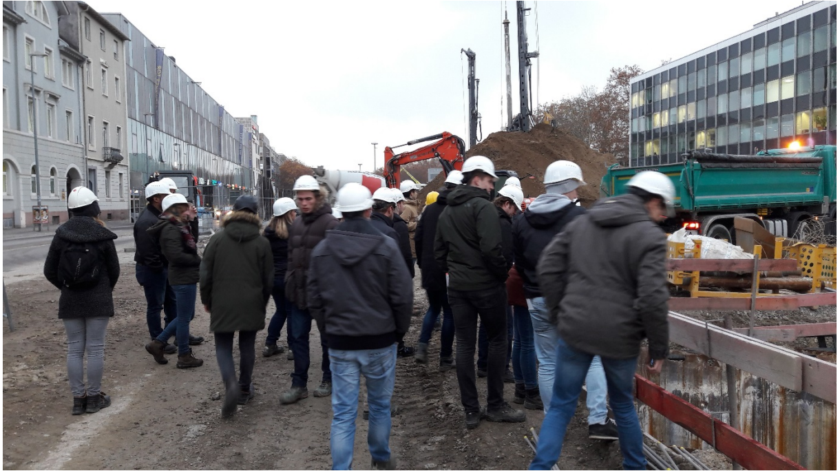
Bild 4: Baustelle Tunnel Kriegsstraße in Karlsruhe; Erläuterungen zur Baumaßnahme
