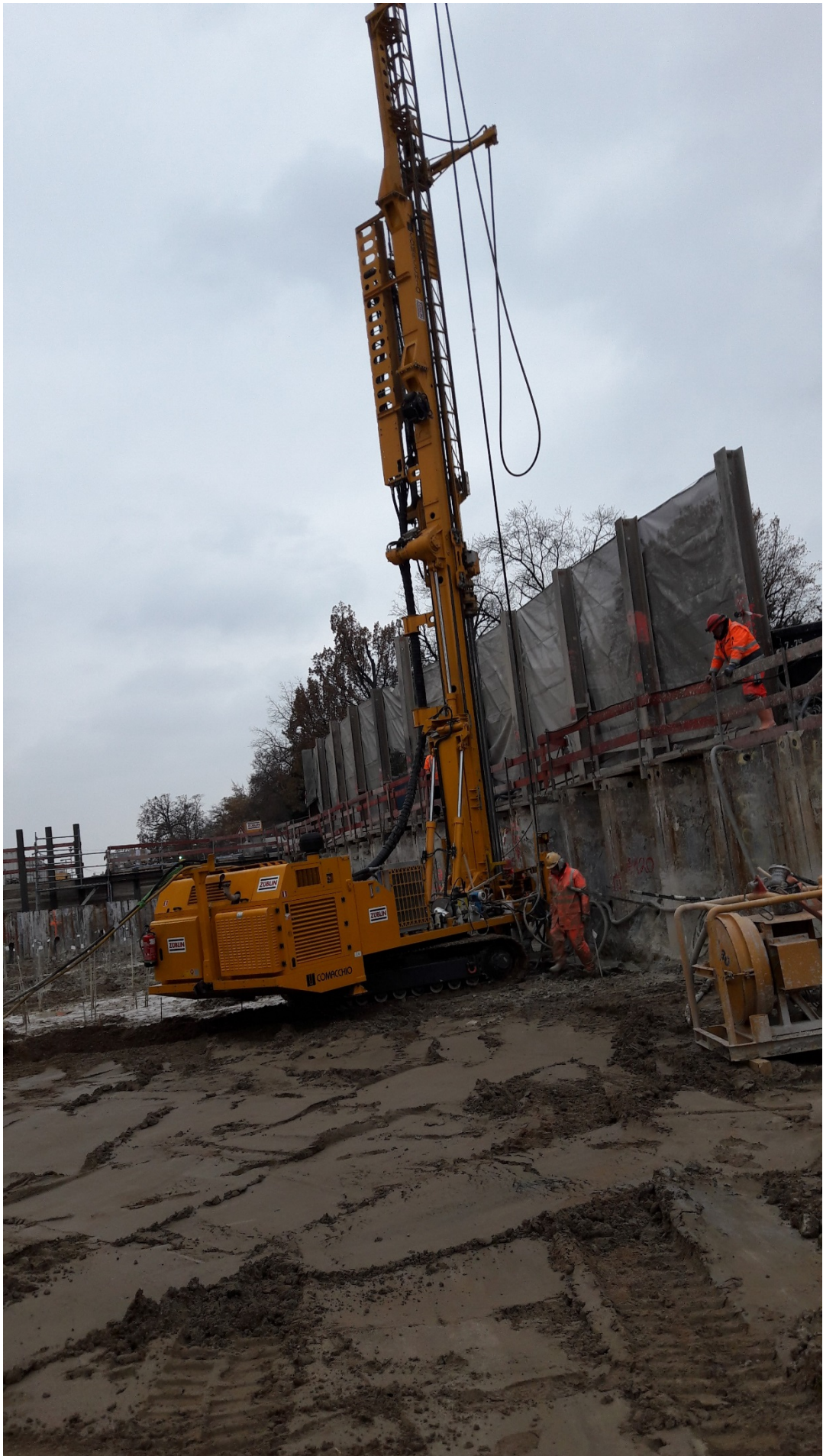
Bild 7: Baustelle Tunnel Kriegsstraße in Karlsruhe; Bohrarbeiten
