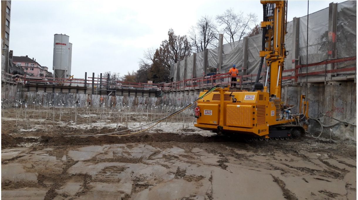
Bild 8: Baustelle Tunnel Kriegsstraße in Karlsruhe; Bohrarbeiten und Weichgelsohle
