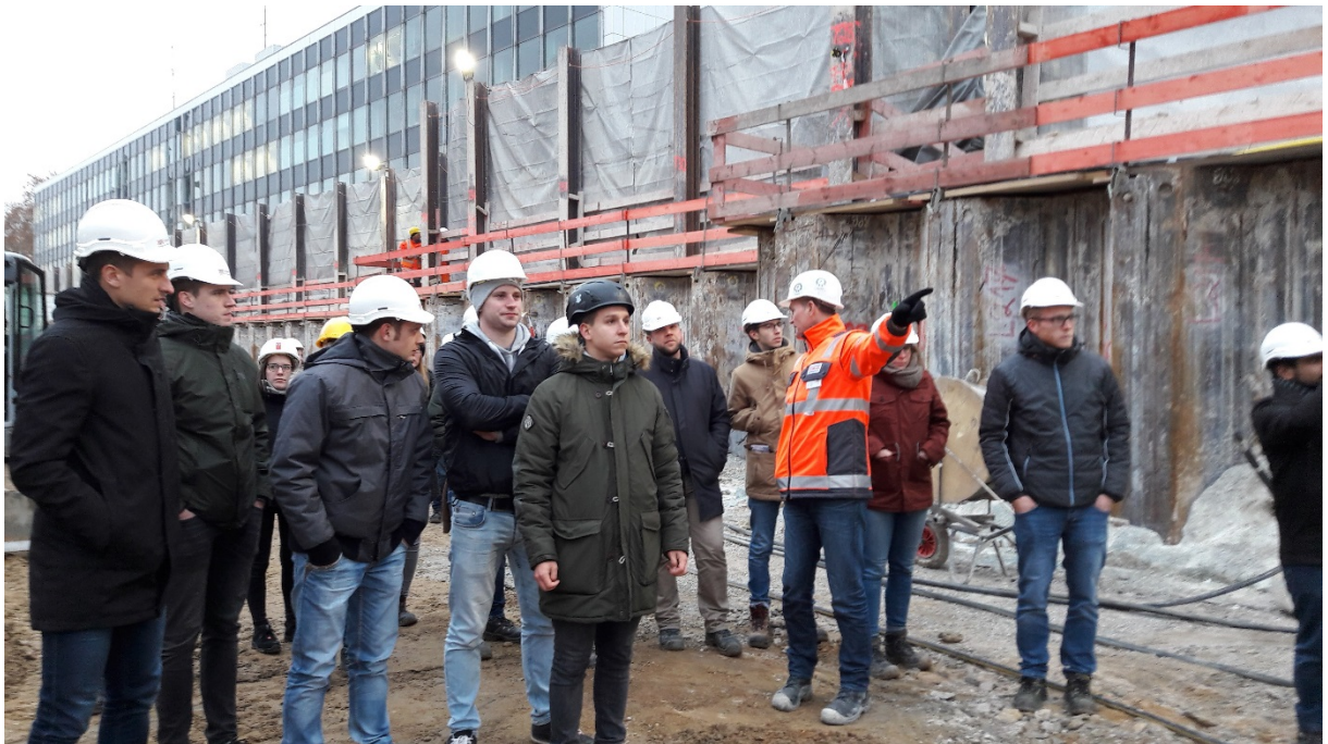
Bild 9: Baustelle Tunnel Kriegsstraße in Karlsruhe; Erläuterungen zur Baumaßnahme
