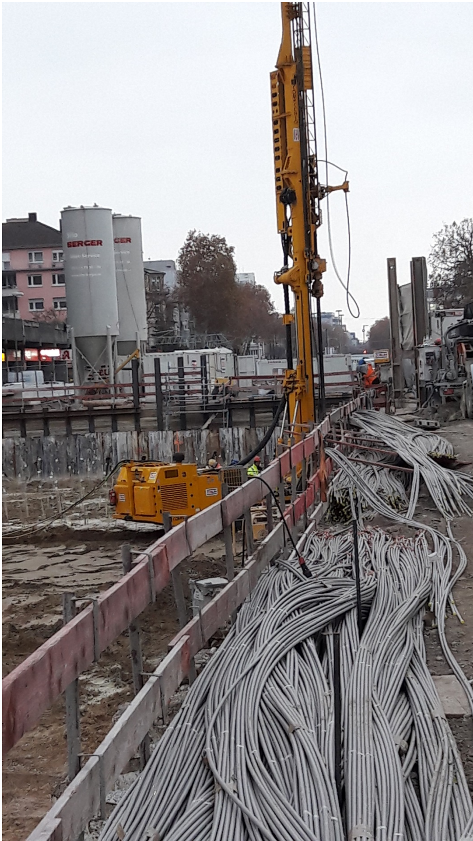
Bild 3: Baustelle Tunnel Kriegsstraße in Karlsruhe; Bohrarbeiten und Baugrubenverbau
