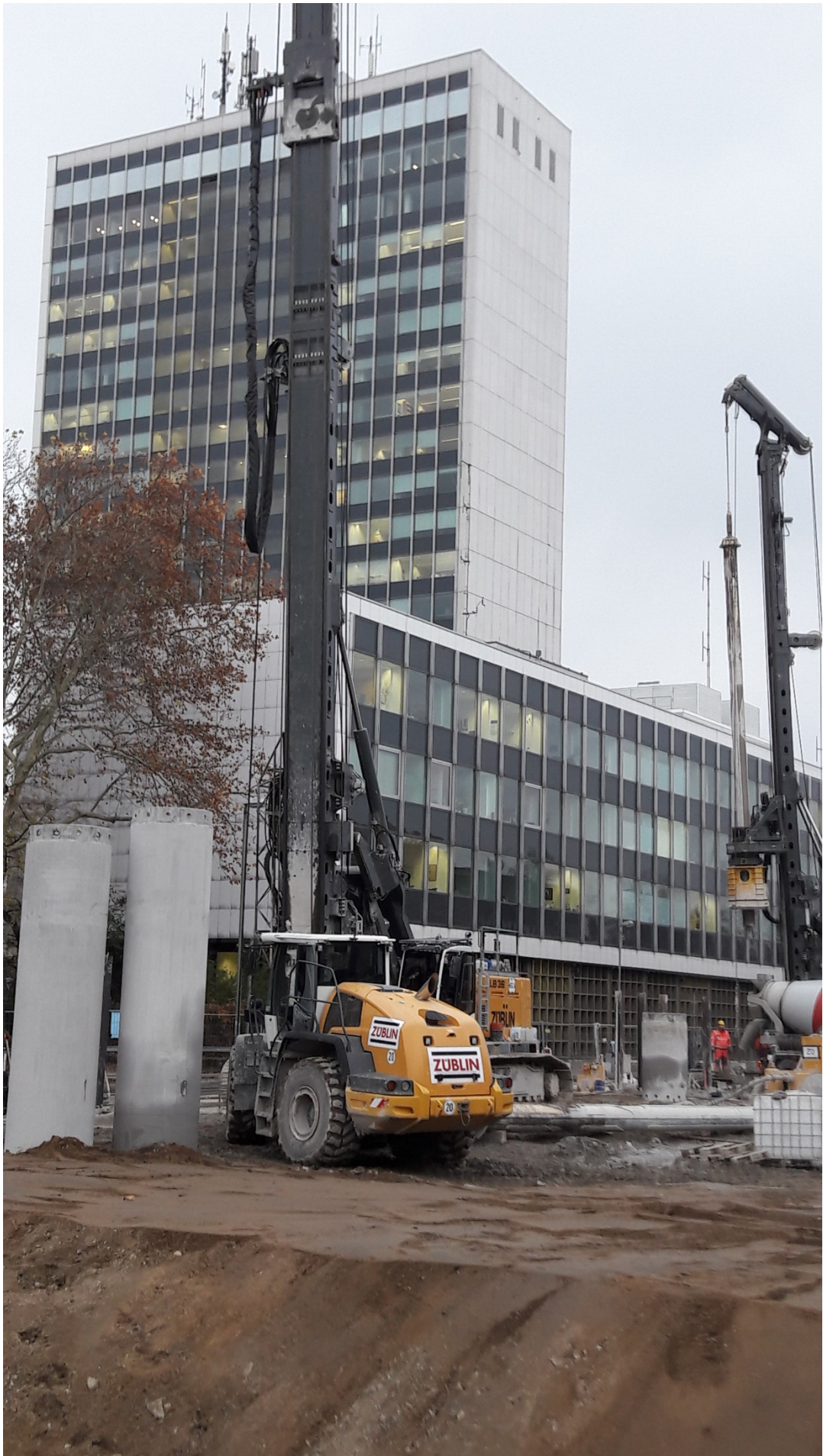
Bild 10: Baustelle Tunnel Kriegsstraße in Karlsruhe; Arbeiten zur Bohrfahlerstellung
